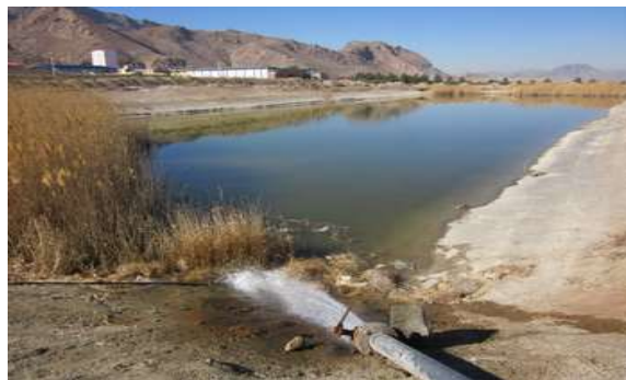
شکل ۱۲- حوضچه ذخیره پساب سیستم نم‌زدایی جهت استفاده مجدد در کشاورزی
