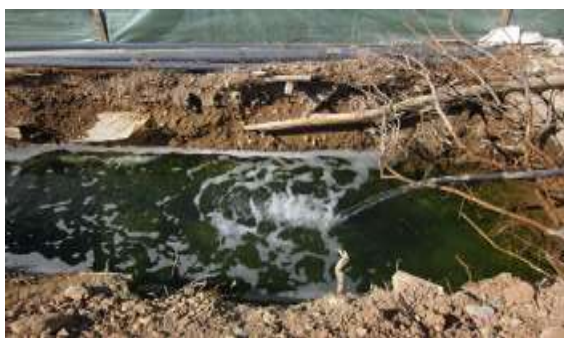
شکل ۱۱- ترانشه حفرشده در مجاورت گلخانه جهت تخلیه پساب سیستم نم‌زدایی
