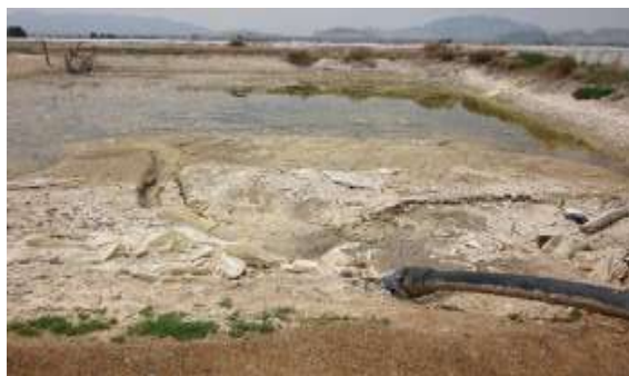
شکل ۱۰- حوضچه بدون پوشش خاکی، محل تخلیه پساب سیستم نم‌زدایی
