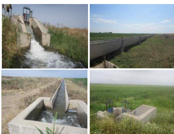
شکل ۲- آبیگر و کانال‌های آبیاری مورد استفاده در آبیاری زمین‌های کشت و صنعت مغان
