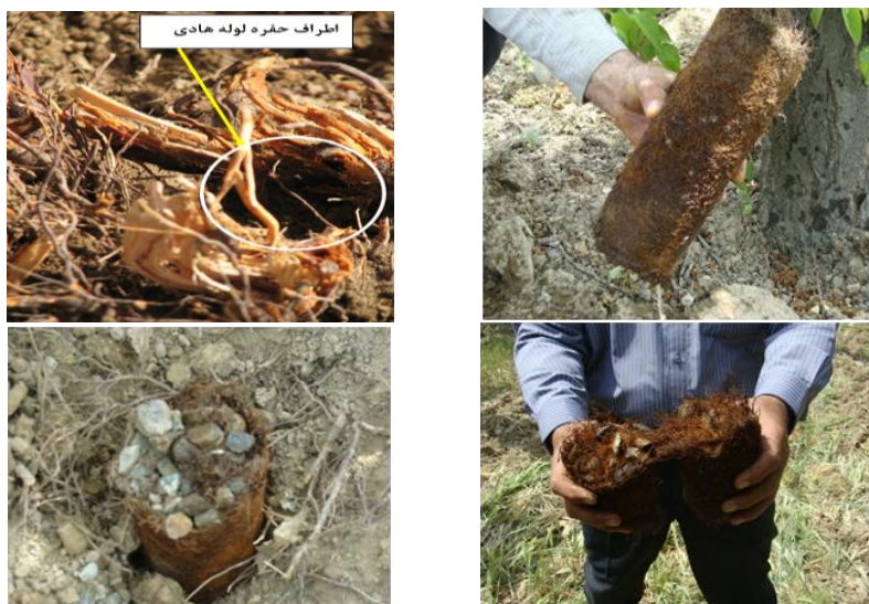
شکل ۶- تجمع ریشه‌های ضخیم در داخل و کف لوله هادی
