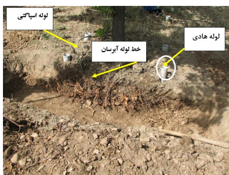
شکل ۱- نحوه آبیاری و قرارگیری قطره‌چکان‌ها در اطراف تنه درخت در سامانه آبیاری زیرسطحی با استفاده از ستون شن
