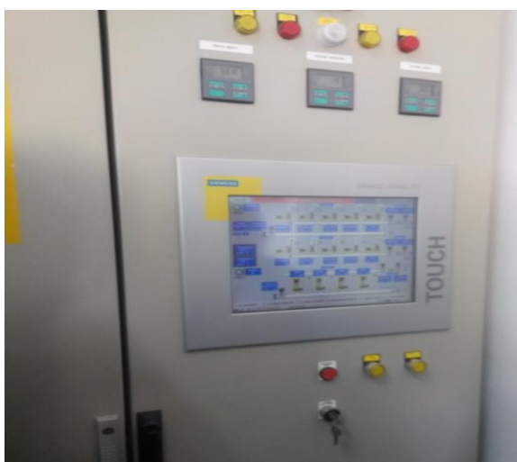
شکل ۲- ایستگاه پمپاژ با قابلیت کارکرد به صورت خودکار (Offanto- Italy).
