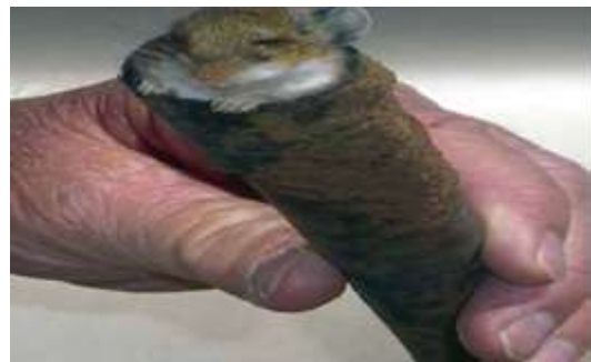
شکل ۶ - نمونه‌ای از آسیب موش به لوله‌های آبدۀ
