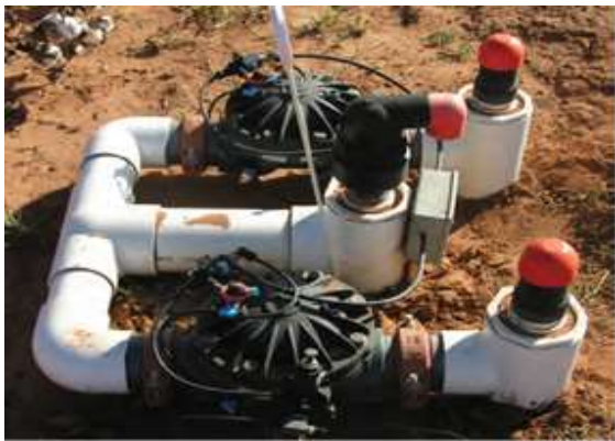
شکل ۳- بکارگیری شیر خلاشکن در سامانه آبیاری زیرسطحی
