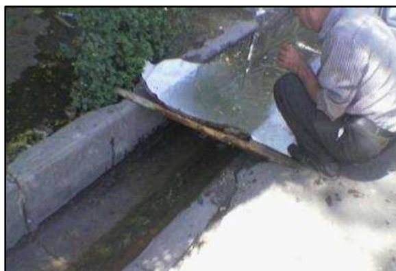
شکل ۱۲- استفاده از یک ابزار ساده (تکه‌ای بشکه و قطعه ای چوب) به عنوان آب‌بند
